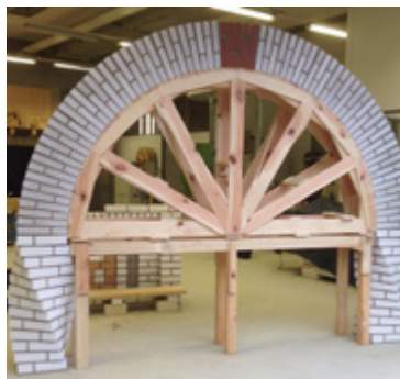
Ausbildungswerkstatt der Maurer und Betonbauer
